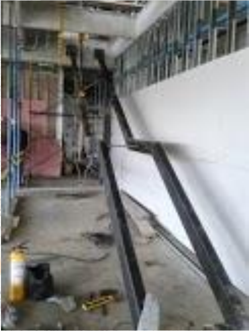
ESCALERA DE GENERAL ELECTRIC: CON VIGA CENTRAL, RECTA, PASOS Y CONTRAPASOS EN GRANITO DE PIEDRA. BARANDA EN ACERO INOXIDABLE
