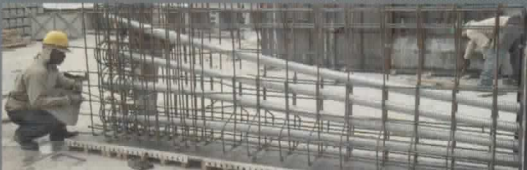
LV. ESTRUCTURAS, ESTACIÓN KRA. 1, MIO - CALI, 2016
